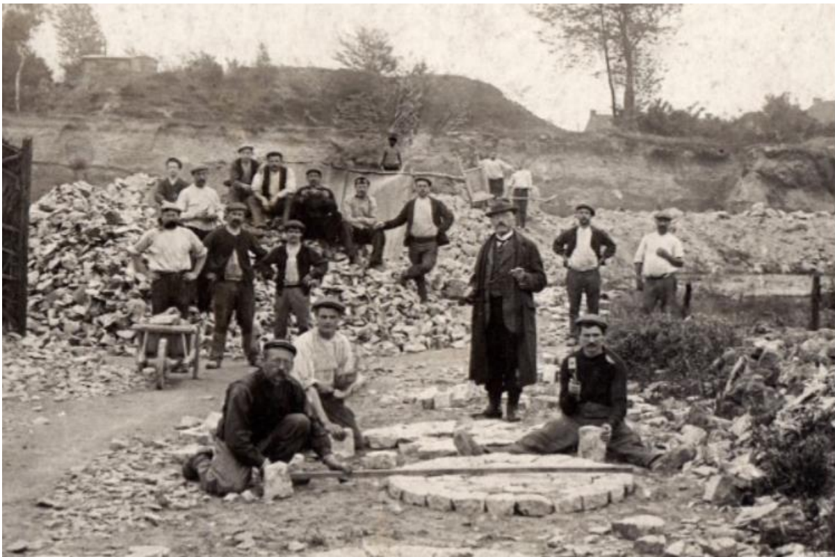
Façonnage de blocs de la base des colonnes du cinquantenaire construites à Bruxelles en 1880 (Archives Rewisbique)
