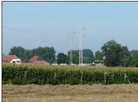
Figure 123 Photographie de la ligne haute tension à Wisbecq
