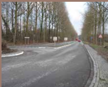
■ Réfection du marquage routier et création d'un marquage d'acheminement cyclable entre la N6 et la N7
