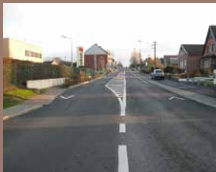
■ Réfection de la Route de Quenast
