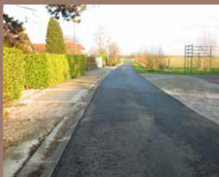
■ Réfection de la Rue de Ham
