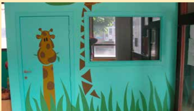
Réfection du réfectoire et de la nouvelle zone de garderie de l'école de la Ruelle Al Tache
