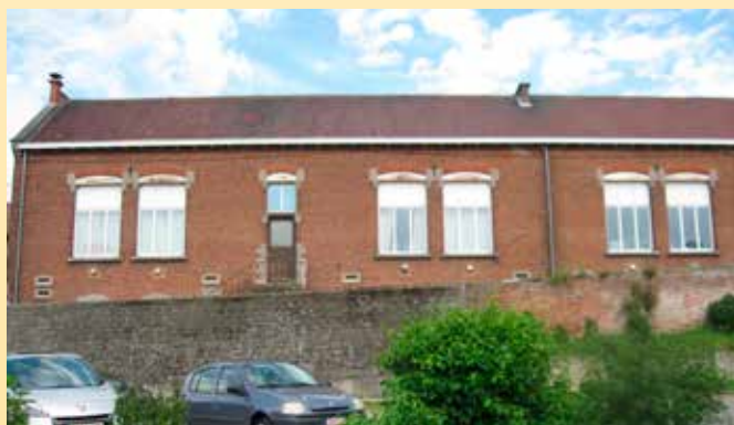
Remplacement des fenêtres et châssis de l'école de la Ruelle Al Tache
