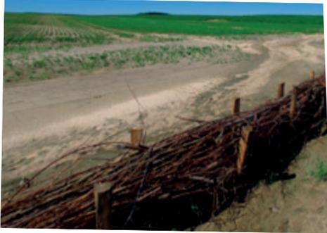
Photo GISER : barrage filtrant
