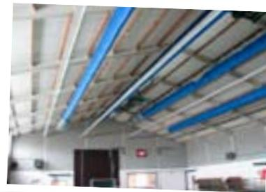
Installation complémentaire de chauffage au Hall Omnisport (déstratification pour régler les problèmes de condensation et de déperdition de chaleur), réalisée grâce à un subside UREBA.
