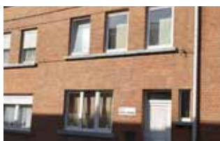
Remplacements des menuiseries extérieures (châssis/portes) aux logements de la rue des frères Demaret au n°34 et au n° 40 pour un montant de 17.000€
