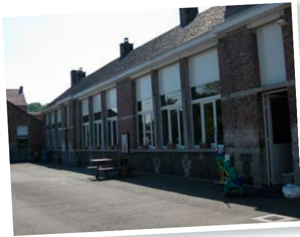
Pose de nouveaux châssis à l'Ecole communale de la Rue de Saintes et à l'Ecole communale de Germinal
