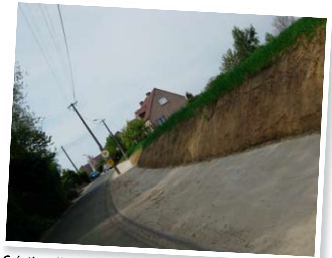
Création d'un trottoir et d'une zone de stationnement au Chemin Planche Quévit.
