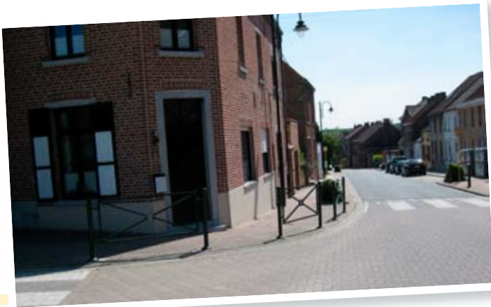
Placement de barrières protectrices à la Rue du Montgras.
