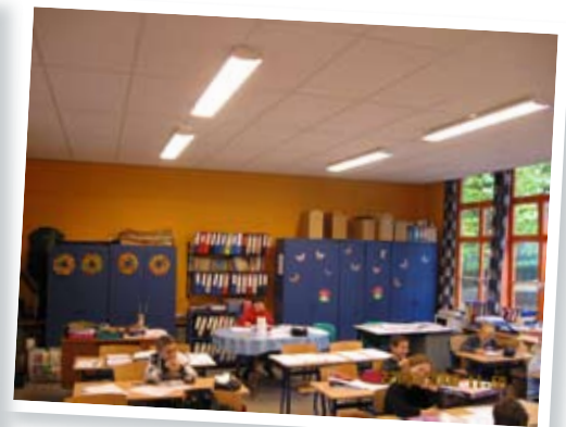
Pose de faux plafonds à la Petite Ecole Bleue
