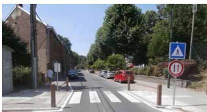
Réalisation d'un effet de porte à la rue du Pont : rétrécissement de la voirie par un élargissement des trottoirs et mise en place d'un ordre de priorité de passage afin de réduire la vitesse.
